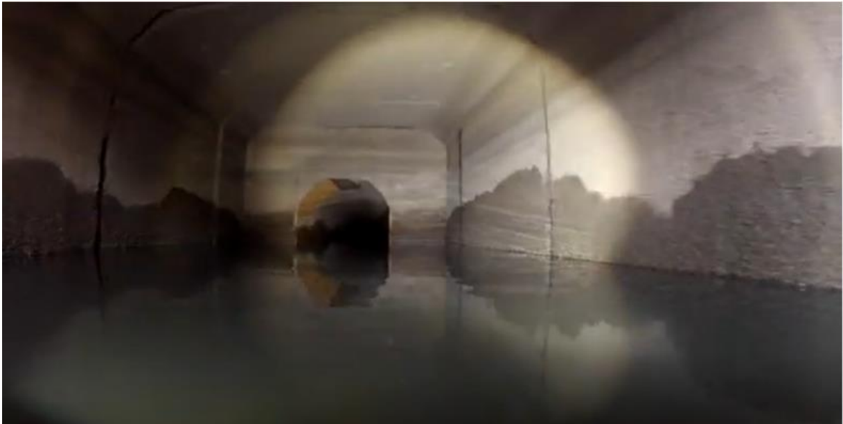
Figura 6 – Saída da galeria a jusante do maciço. Quatro aduelas retangulares de concreto.
